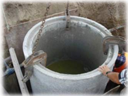
Execução de caixa de visita
