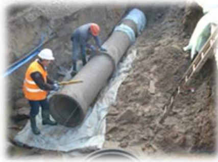
Instalação de coletor pluvial
