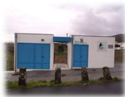
Estação elevatória de águas residuais
