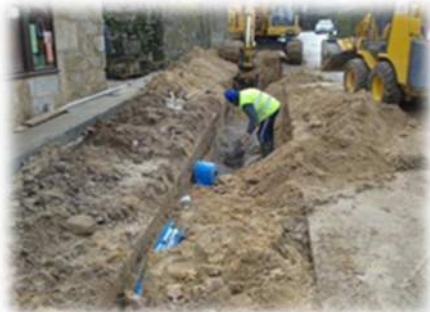
Instalação da conduta de água
