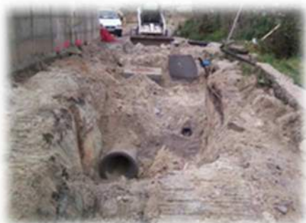
Instalação do coletor pluvial
