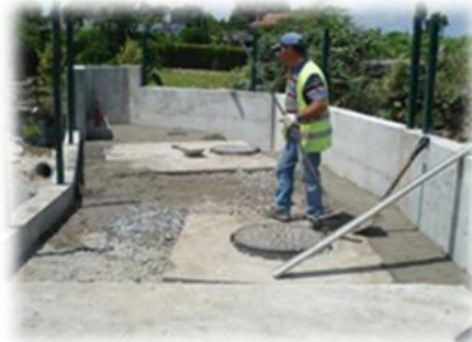
Acabamentos na estação elevatória
