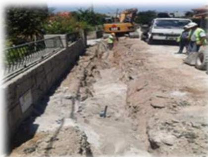
Instalação da conduta de água Couto
