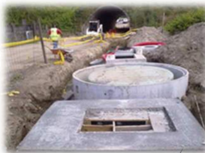
Execução de estação elevatória
