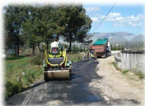
Trabalhos de pavimentação betuminoso
