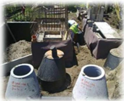
Execução da estação elevatória
