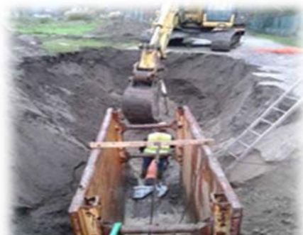
Instalação de coletor de águas residuais
