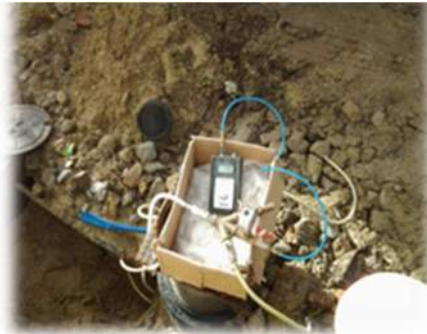
Ensaio de estanquidade à rede residual
