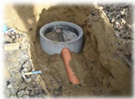
Execução de caixa de visita
