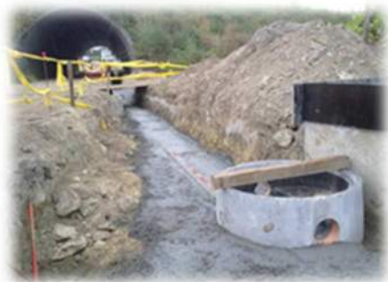
Instalação de rede de saneamento
