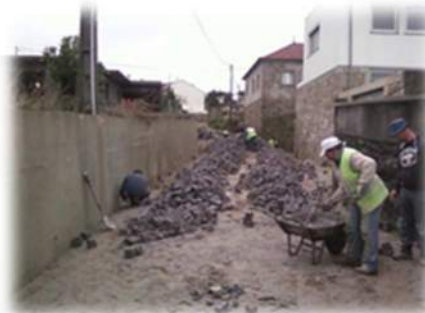
Trabalhos de pavimentação em cubo
