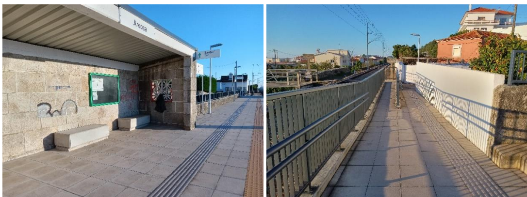
Figura 123. Características infraestruturais da plataforma do Apeadeiro Ferroviário de Areosa
