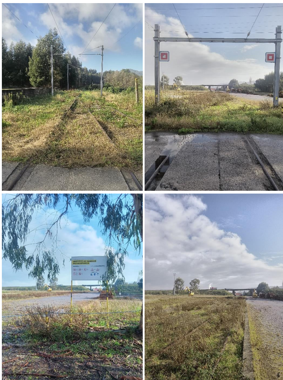
Figura 156. Parque Exterior de Madeiras (The Navigator Company) e ferrovia de acesso inativa
