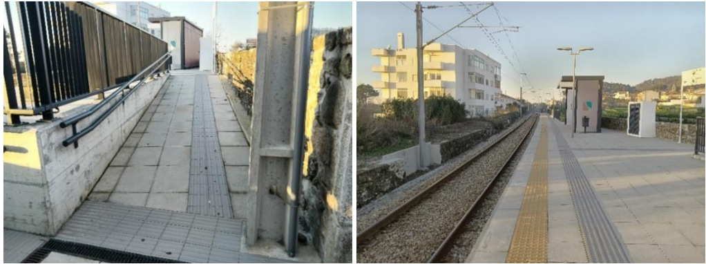
Figura 105. Características infraestruturais da plataforma do Apeadeiro Ferroviário de Afife
