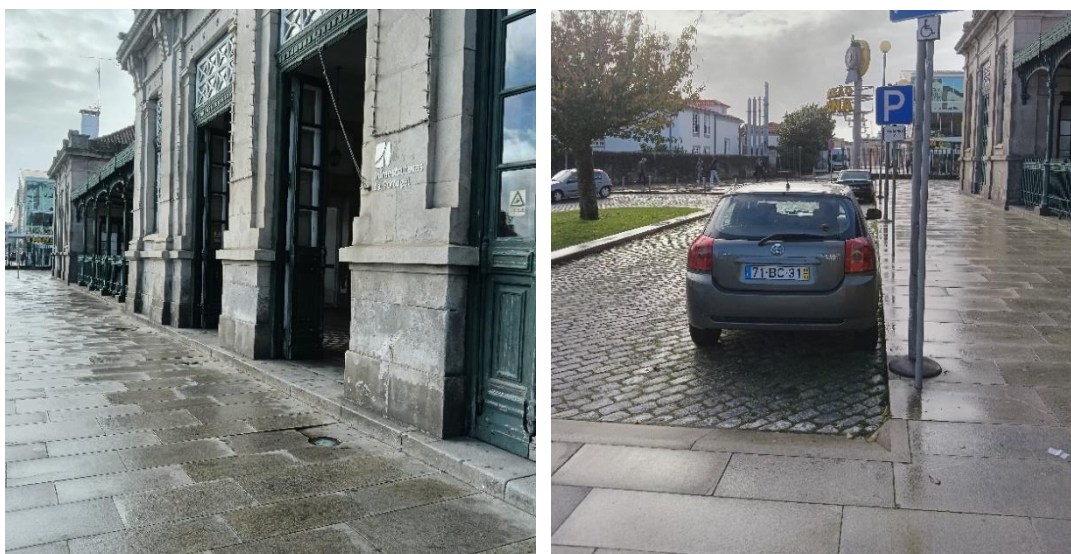
Figura 95. Características infraestruturais associadas ao acesso pedonal através do Largo da Estação
