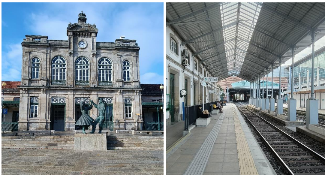
Figura 93. Estação Ferroviária de Viana do Castelo
