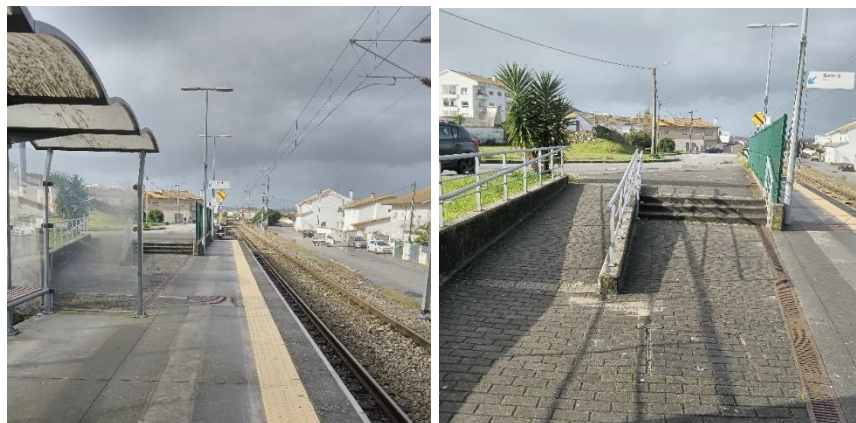
Figura 108. Características infraestruturais da plataforma do Apeadeiro Ferroviário de Areia-Darque
