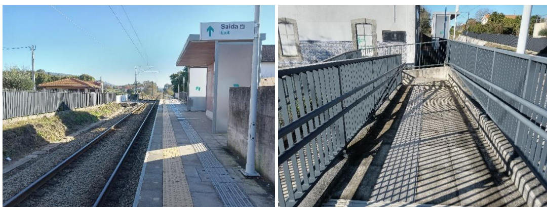
Figura 126. Características infraestruturais da plataforma de embarque do Apeadeiro Ferroviário de Alvarães
