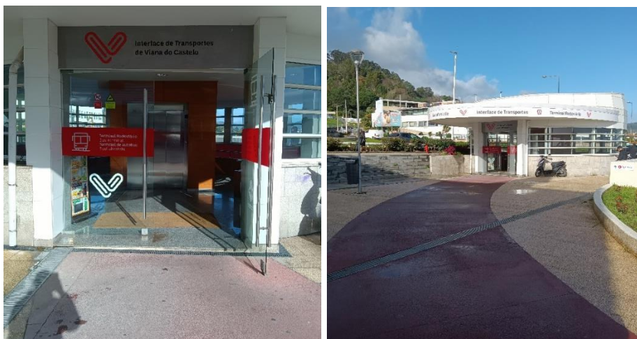
Figura 98. Terminal Rodoviário de Viana do Castelo
