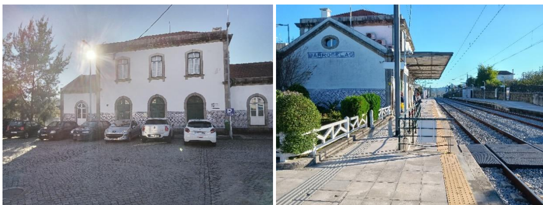
Figura 112. Estação Ferroviária de Barrocelas
