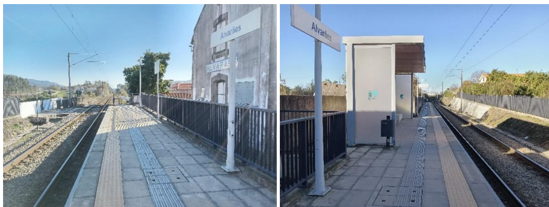
Figura 124. Apeadeiro Ferroviário de Alvarães
