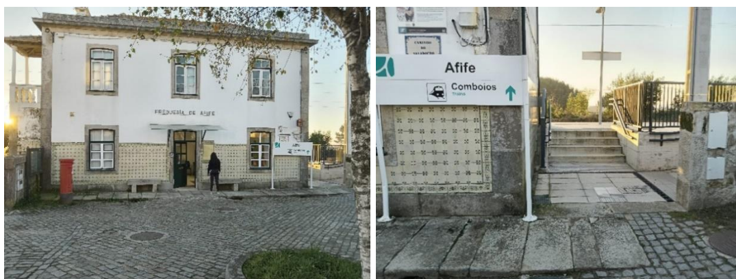
Figura 103. Apeadeiro Ferroviário de Afife
