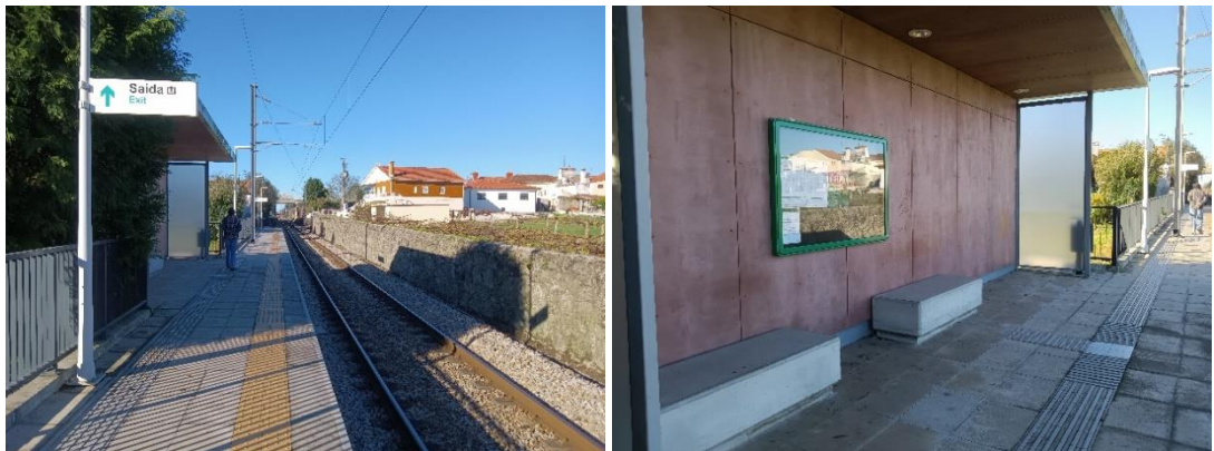
Figura 129. Características infraestruturais da plataforma do Apeadeiro Ferroviário de Nossa Senhora das Neves
