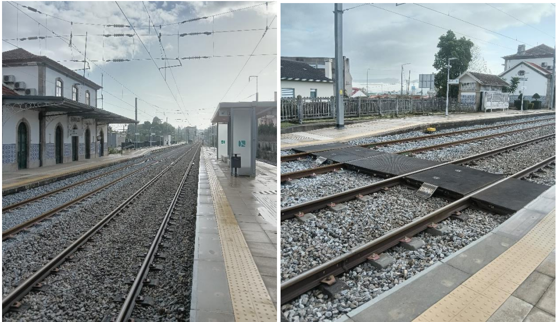
Figura 111. Características infraestruturais das plataformas de embarque da Estação Ferroviária de Darque e acesso pedonal entre ambas as plataformas
